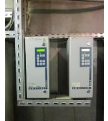
Частотные преобразователи
