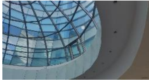
Фрамуги в зенитном фонаре с автоматическим управлением
