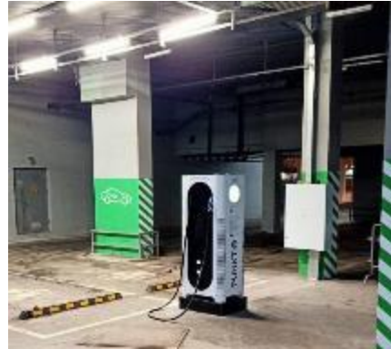
Станция зарядки электромобилей
