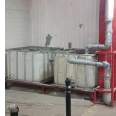
Система сбора ливневых вод
