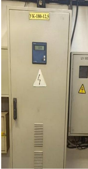
Компенсатор реактивной мощности
