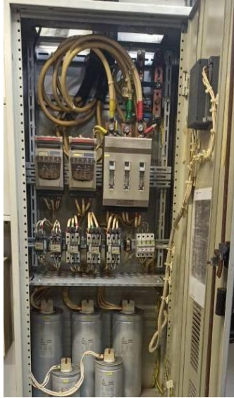
Компенсатор реактивной мощности
