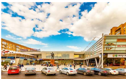
ТК «Галерея Аэропорт» м. Аэропорт Общая площадь – 12 000 кв. м.
